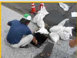
⑤側溝に流出した事を想定した、オイル汲み取り方法の訓練
