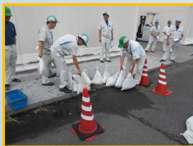
④パイロンで汚染場所を隔離し、土嚢・オイル吸着剤にて拡散防止
